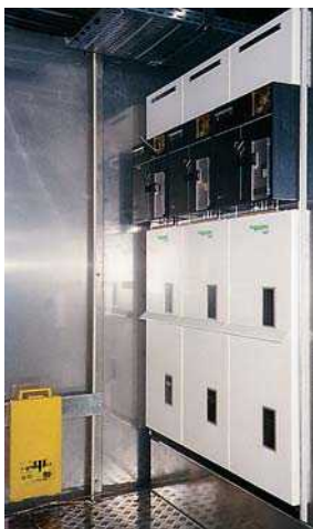
Sobrelevação das células 400 - 630 A sobre base 350 mm
