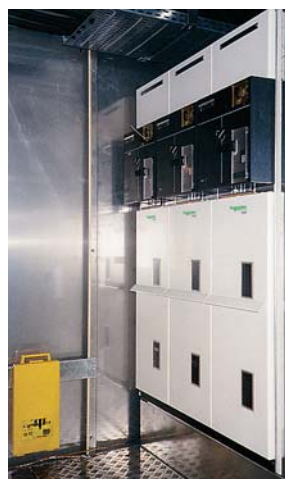
Sobrelevação das células 400 - 630 A sobre base 350 mm
